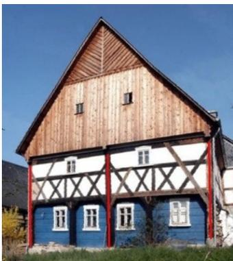
Abb. A-6 Langständer(misch)bau (Oberseifersdorf (Foto: Bühler, bearbeitet))
