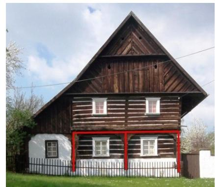
Abb. A-8 Stockwerkbau, aber Oberstock in Blockbauweise (Lhota u Ústěku)
