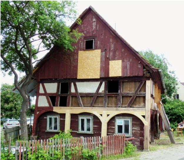
Deformationen, die im Laufe der Zeit bei vielen, vorwiegend aus Holz errichteten Bauwerken auftreten, können belassen werden, wenn aus baustatischer Sicht keine Bedenken bestehen. Die Gebrauchsfähigkeit muss jedoch gegeben sein.
