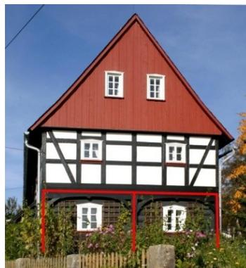
Abb. A-7 Stockwerkbau (Waitzdorf)
